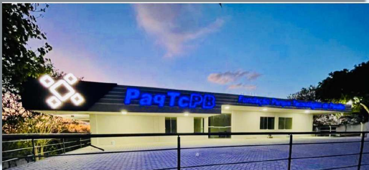
Figura 12 – Sede principal da Fundação PaqTcPB
