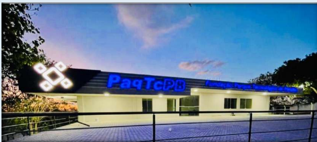
Figura 11 – Sede principal da Fundação PaqTcPB
