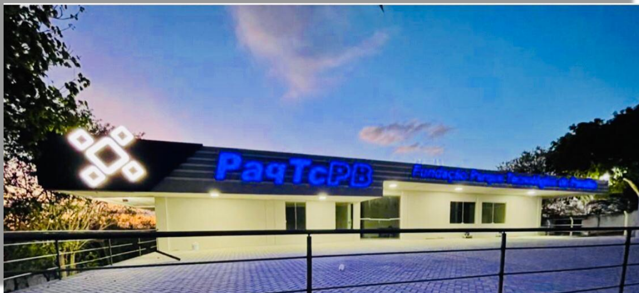
Figura 6 – Sede principal da Fundação PaqTcPB
