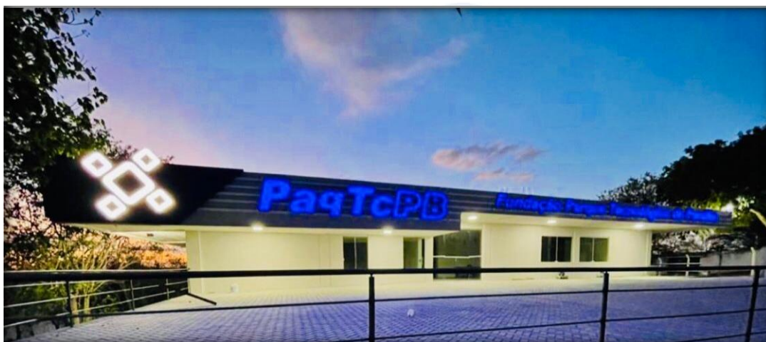
Figura 5 – Sede principal da Fundação PaqTcPB
